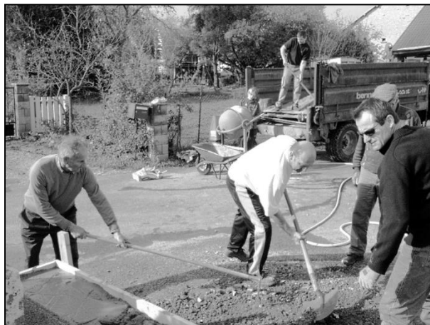
Travaux lors de la réinstallation du calvaire suite au démontage du transformateur EDF (octobre 2011)
